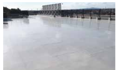
屋上防水改修後
